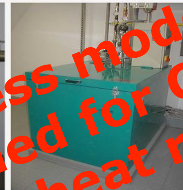
CHP Bremer Höhe 18 kW el / 42 kW th
