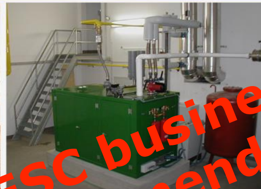
CHP Pulvermühle 50 kW el / 95 kW th
